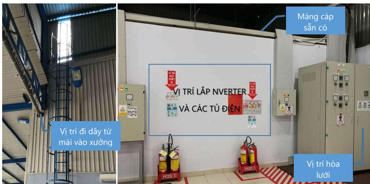
Như hình trên: có chỉ rõ vị trí đi dây từ trên mái (vị trí lắp các tấm pin) đến vị trí lắp inverter và các tủ điện đóng cắt và bảo vệ.
