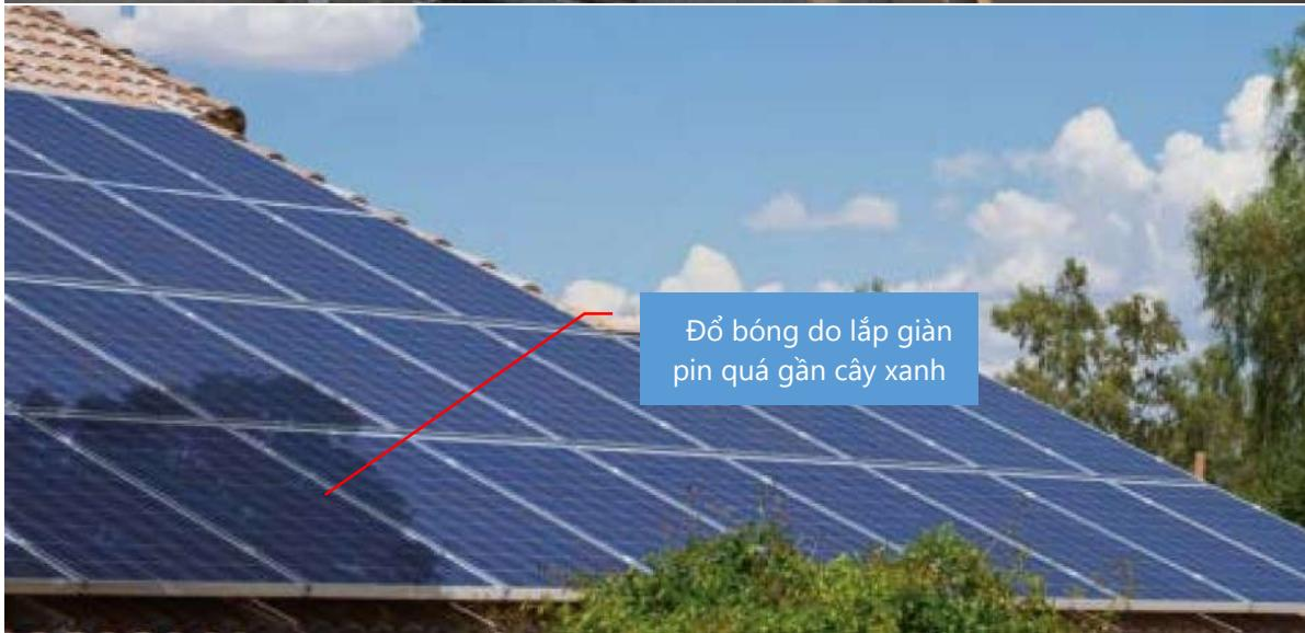
Dàn pin nên được chiếu sáng ít nhất 6 giờ không bị đổ bóng để thu được lượng công suất cao nhất có thể. Lý tưởng nhất là không có đổ bóng trong khoảng thời gian từ 8h sáng đến 16h chiều, do đây là thời điểm bức xạ mặt trời cao nhất trong ngày. Tuy nhiên điều này khó có thể đạt được và cần cân nhắc đến vị trí cụ thể của dàn pin cũng như khi giảm thiểu tối đa các vật thể gây đổ bóng (VD: tia bớt hoặc chặt bớt cây).
